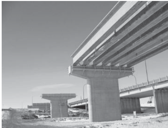
Manitoba floodway expansion Agrandissement du canal de dérivation du Manitoba
